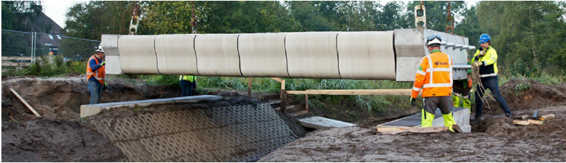
Рис. 2. Сборный мост, изготовленный методом 3D-печати [3]
