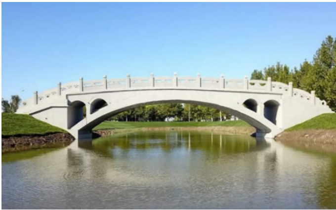
Рис. 3. Бетонный арочный мост, изготовленный методом 3D-печати [4]
